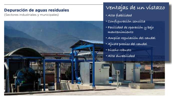
La depuración moderna de aguas residuales requiere el movimiento de grandes volúmenes de aire a baja presión y la gama de soplantes PD de Robuschi proporciona una fuente fiable de aire para los diferentes procesos.
